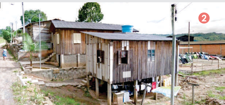
17. Autoconstrução em pilotis e madeira, Siderópolis (Google Maps)
